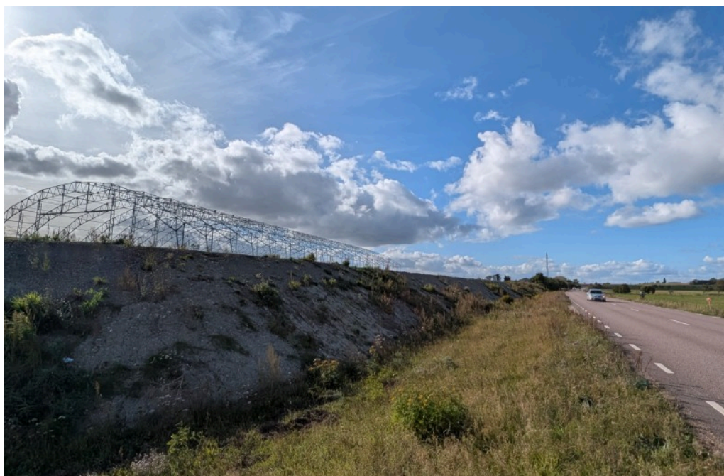
Figur 5. Foto från nordost där den nybyggda skyddsvallen och takkonstruktion enligt givet bygglov, samt Elisedalsvägen syns. Takkonstruktionen avses täckas med ljus duk. Den äldre skyddsvallen och dess vegetation syns längre bort i bild.
